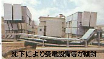
沈下により受電設備等が傾斜
